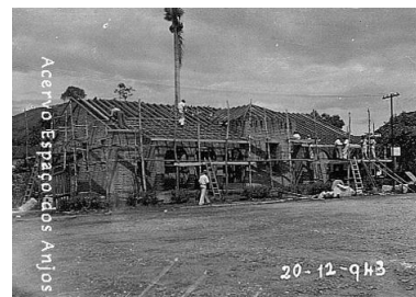
Lactário em construção
